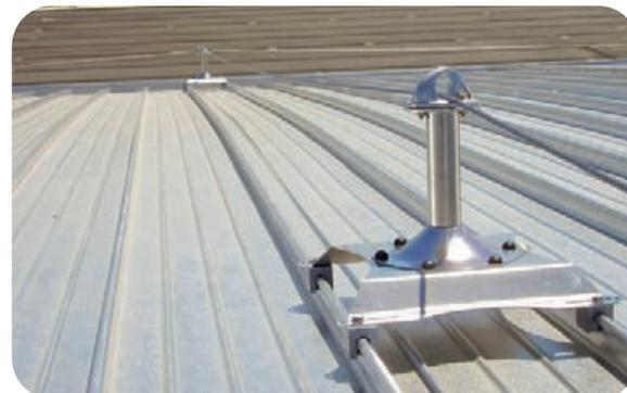
Avec une ligne de vie plus haute sur la couverture, il devient plus commode à utiliser et admet des travées plus larges pour la pose des ancrages.
