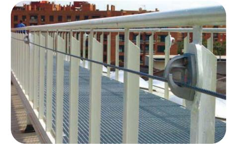
Détail montage plaques PS14 sur structure métallique
